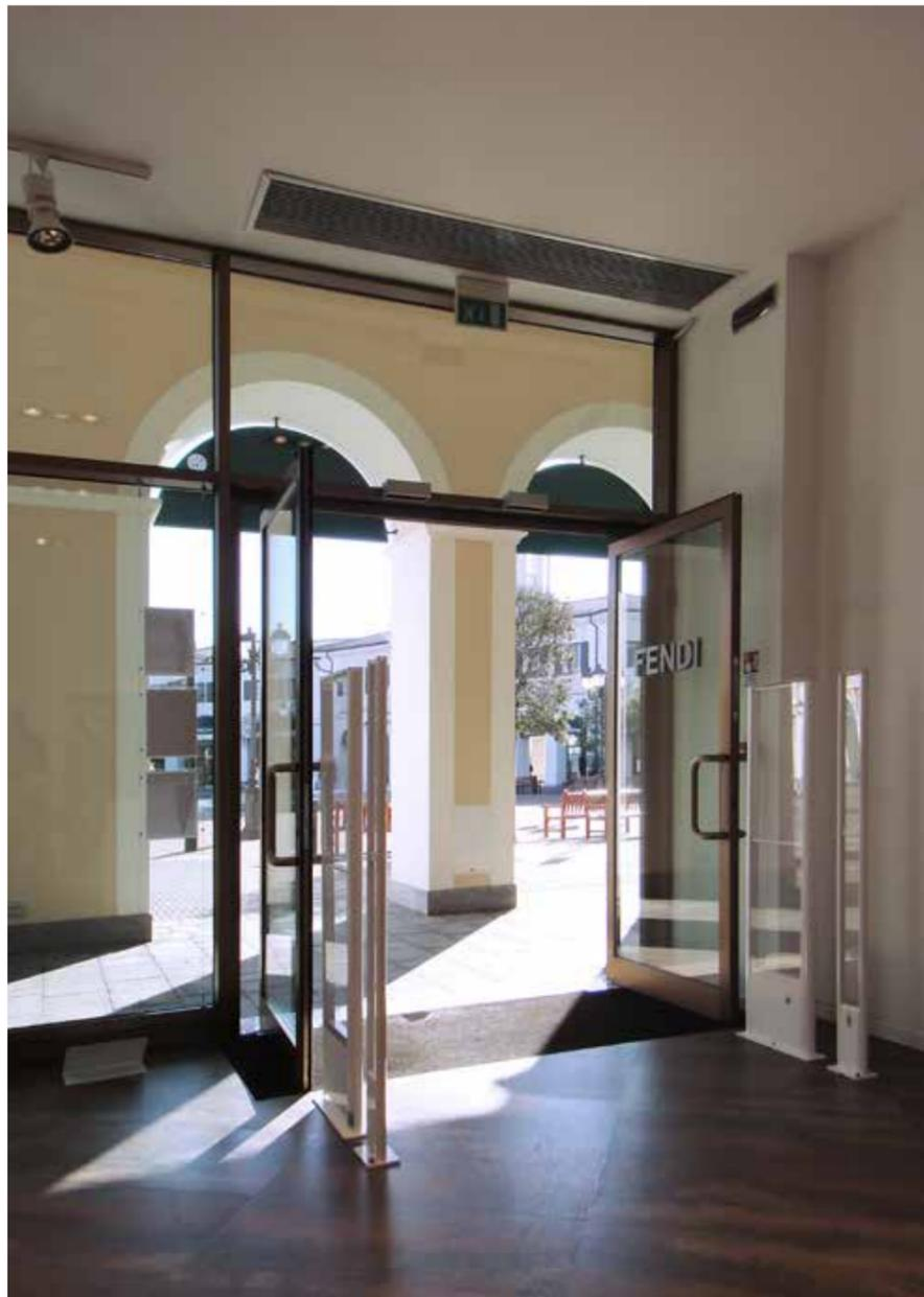
78 | Grazie al loro ingombro ridotto ed alla griglia combinata di aspirazione e mandata dell'aria, le barriere ad incasso Proter si possono installare in appena 30 centimetri di spazio. Due to their space saving dimensions and the combined air inlet and outlet grille, the Proter recessed air curtains can be installed in just 30 centimeters of space.
