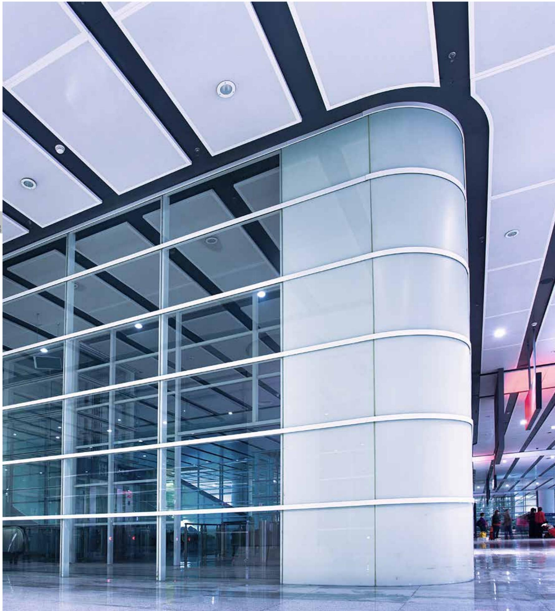
Piano M è un soffitto radiante formato da pannelli autoportanti di grandi dimensioni. Si installa sospeso in modo da formare un controsoffitto a più livelli in cui la parte superiore può essere un ribassamento in cartongesso o il solaio stesso.
