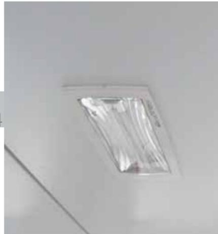
34 | Nel soffitto radiante Kappa Hospital si integrano lampade, diffusori d'aria e sensori. I pannelli sono forniti pretagliati per facilitare e velocizzare l'installazione.
