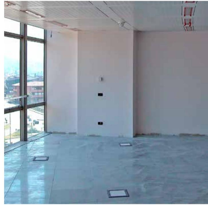
Proterfloor M unisce i vantaggi del pavimento sopraelevato al comfort del pavimento radiante. Le plote autoportanti sono in acciaio con scambiatore di calore in rame. Il rivestimento può essere incollato alla plotta oppure indipendente e posato in secondo momento in cantiere.
